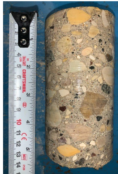
Figure 44 – Core No. 83 (Kullman St)
